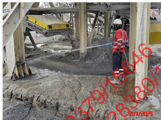
รูปที่ 9 ลานล้างล้อรถบรรทุก
