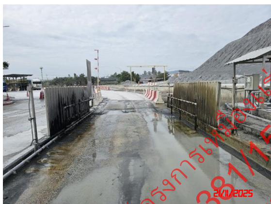
รูปที่ 9 ลานล้างล้อรถบรรทุก
