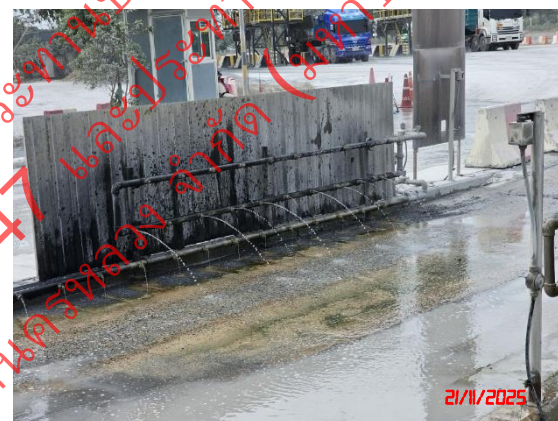
รูปที่ 9 ลานล้างล้อรถบรรทุก
