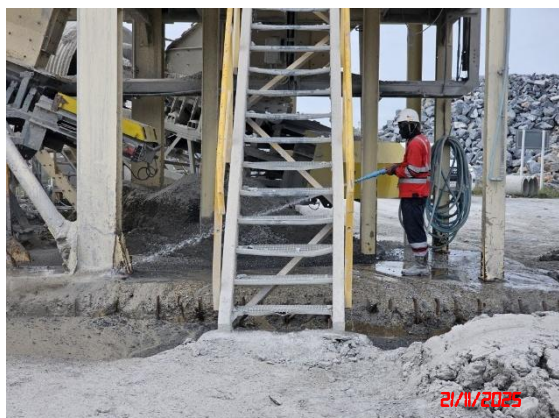
รูปที่ 9 ลานล้างล้อรถบรรทุก
